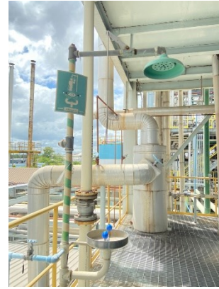
รูปถ่ายที่ 3.2-24 : ฝักบัวและอ่างล้างตาฉุกเฉิน
