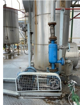
รูปถ่ายที่ 3.2-2 : Vacuum pump สำหรับดูดฝุ่นของ PA
