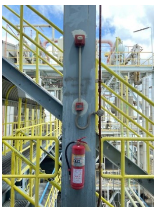
รูปถ่ายที่ 3.2-37 : Fire Alarm Call Point
