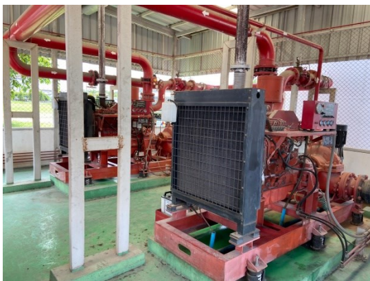
รูปถ่ายที่ 3.2-41 : เครื่องสูบน้ำดับเพลิงขนาด 375 ลูกบาศก์เมตร/ชั่วโมง
