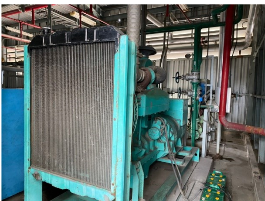
รูปถ่ายที่ 3.2-11 : เครื่องกำเนิดไฟฟ้าสำรอง
