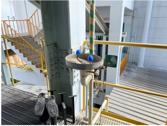
รูปถ่ายที่ 3.2-24 : ฝักบัวและอ่างล้างตาฉุกเฉิน
