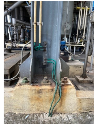
รูปถ่ายที่ 3.2-31 : อุปกรณ์ป้องกันกระแสไฟฟ้ารั่วและสายดิน
