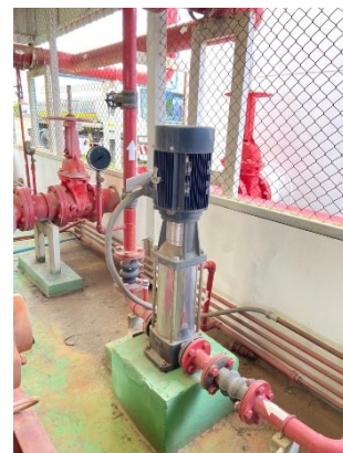
รูปถ่ายที่ 3.2-40 : ปั๊มน้ำดับเพลิงแบบไฟฟ้าขนาด 180 ลูกบาศก์เมตร/ชั่วโมง
