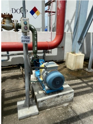
รูปถ่ายที่ 3.2-7 : เครื่องจักรติดตั้งบนแท่นคอนกรีต
